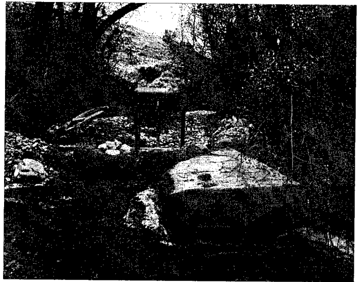
4: ROCK POURING DITCH
