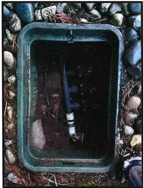
Photos 2 A & B- Control valves (8 total).
