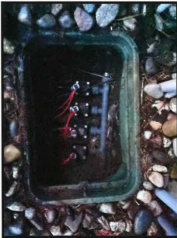
Photos 2 A & B- Control valves (8 total).
