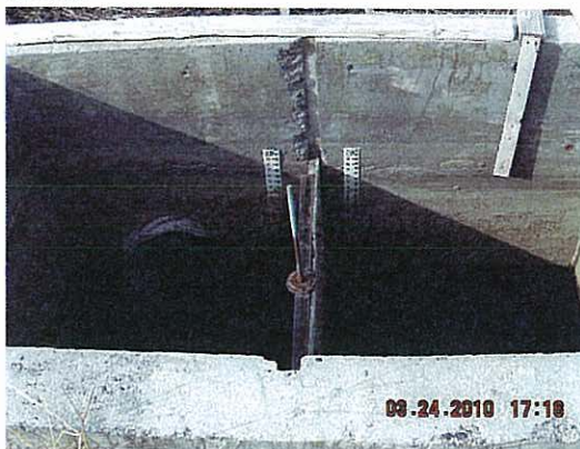
S. & S. King submerged orifice Gate
