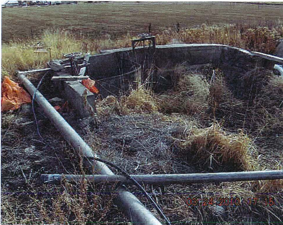
S. & S. King submerged orifice Gate
