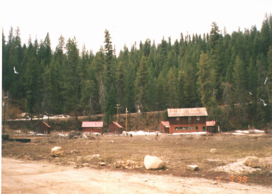
5 cabins + equip bldg
