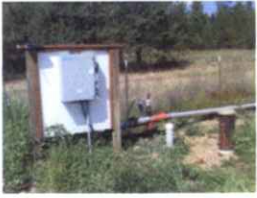
ELEC BOX 15 HP 135GPM.jpg
