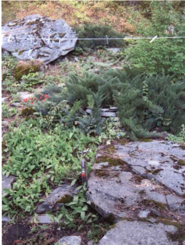
95-9273 Irrigation Riser 1.jpg
