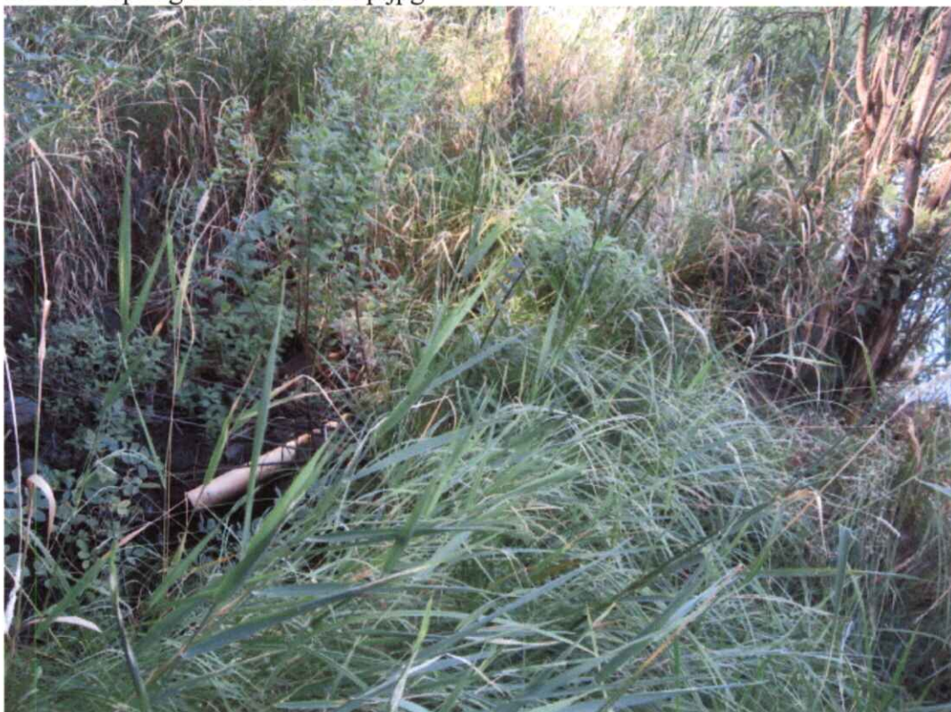
95-9273 Spring 3 Pipe To Pond.jpg
