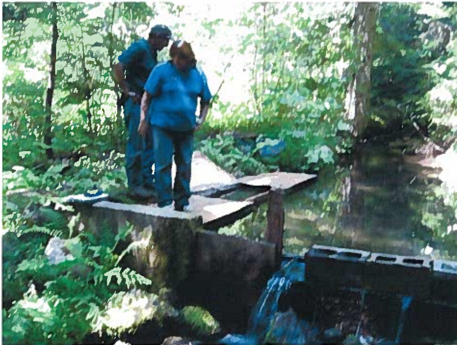
92-7171 Adams CR Pipe Inlet.jpg
