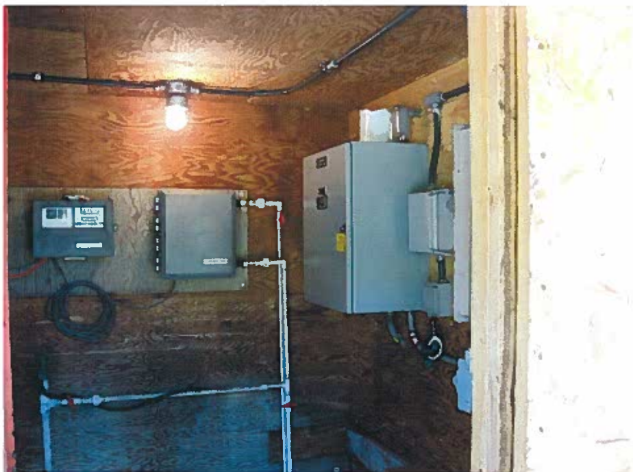
92-7171 Finn CR Reservoir Meter House.jpg
