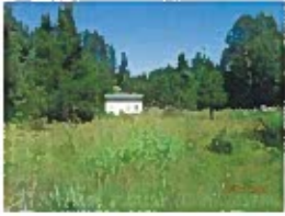
PUMP HOUSE 1.JPG
