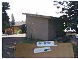
pump house (2).JPG
