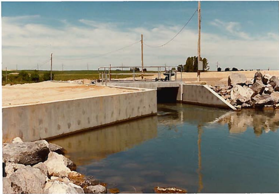
C Canal Diversion
