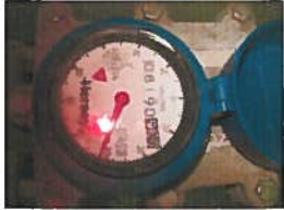
Flow -Well D0022417.JPG
