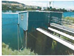
POD 1 SW PUMP STA.JPG
