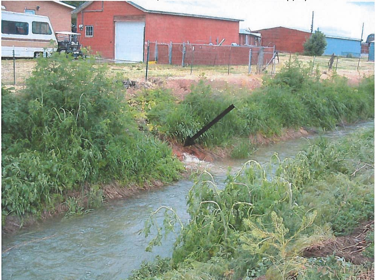
Effluent discharge to Purdam Drain
