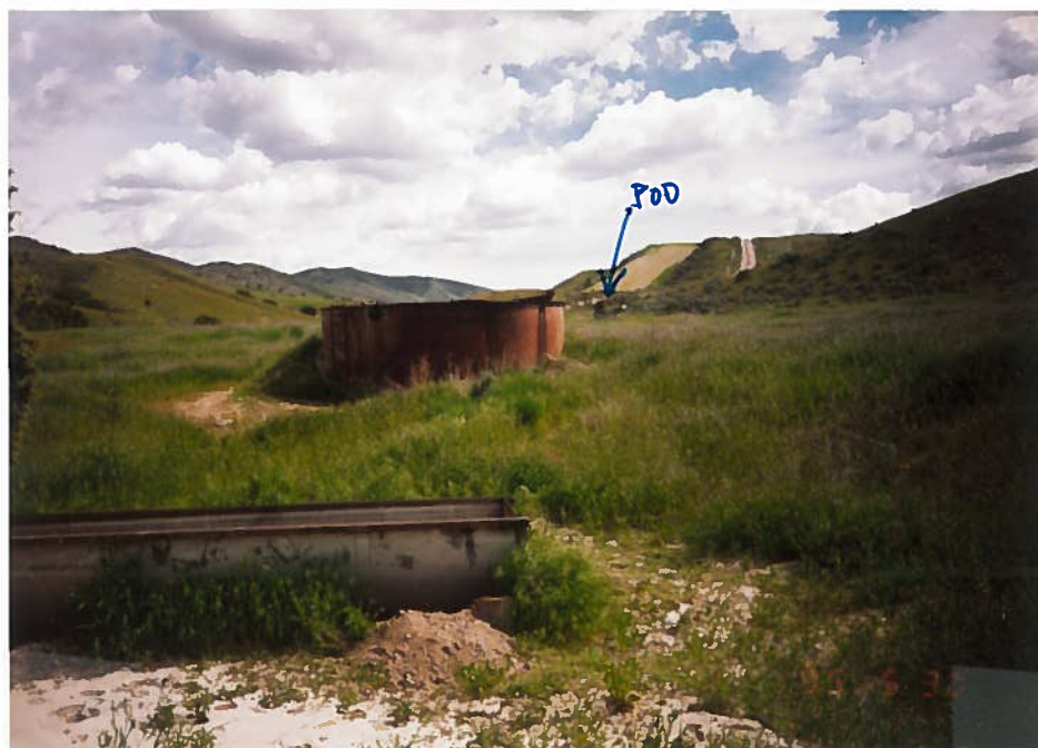
Trough & Tank pou.
